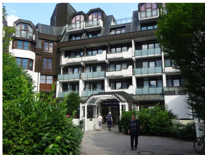
Hotel „Amber Bavaria“ in Bad Reichenhall
